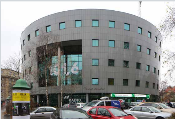
Siedziba Radia Kraków, Al. Słowackiego 22 Fot. A. Janikowski
